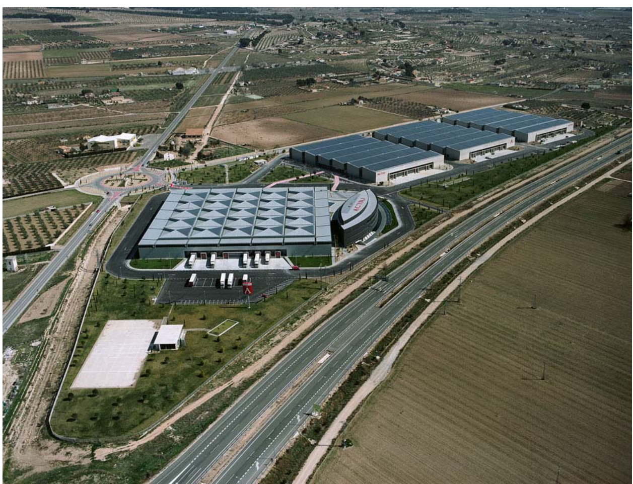
Ilustración 1: Parque Tecnológico Actiu 5, 3 MW. instalados por MAYGMÓ
